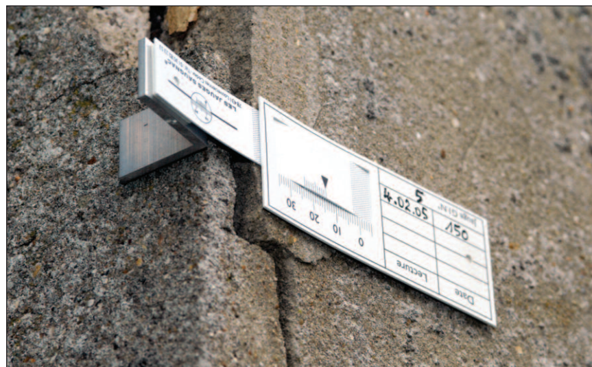
Pose d'une jauge G1 sur fissure de rive avec une cornière aluminium
